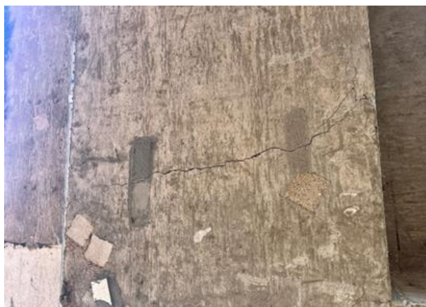
Figura 28 - Face inferior da viga 107.
