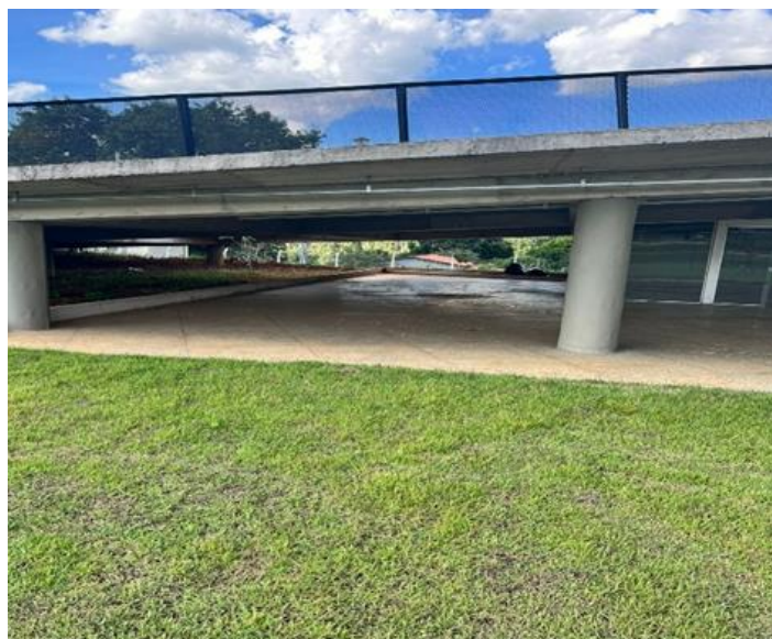
Figura 23 - Estrutura interna da rampa e dos pilares.
