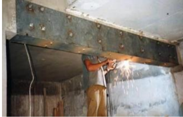
Figura 45 - Colagem de chapa metálica em viga de concreto.
