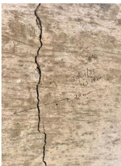
Figura 27 - Fissura viga 101.
