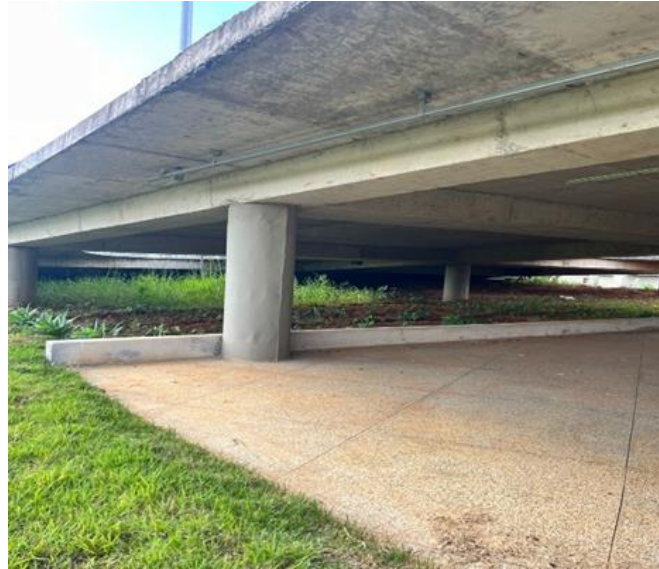
Figura 24 - Estrutura interna da rampa e das vigas.
