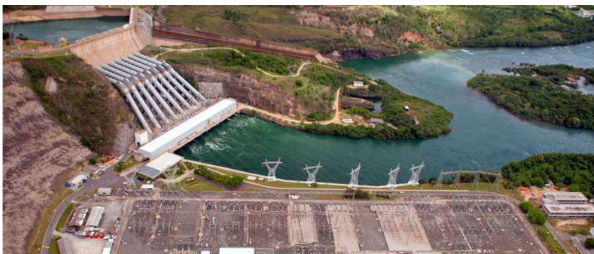
Figura 1: Vista panorâmica do Reservatório de Furnas
