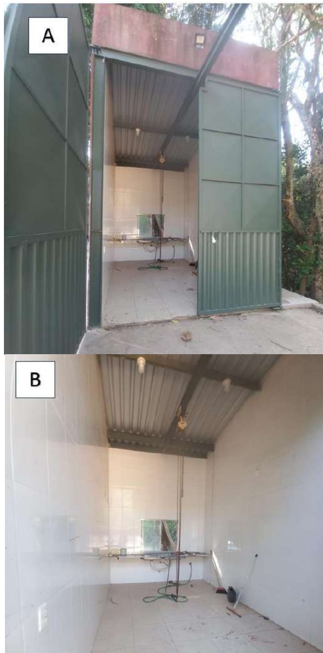
A: Vista externa. B: Vista interna. Fonte: Do autor (2023).
