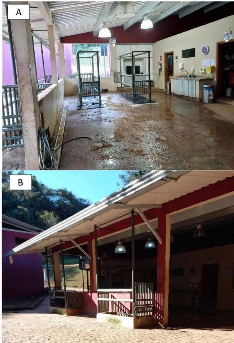
A: Vista parcial da clínica de atendimento, com troncos de contenção; B: Troncos de contenção para crioterapia. Fonte: Do autor (2023).
