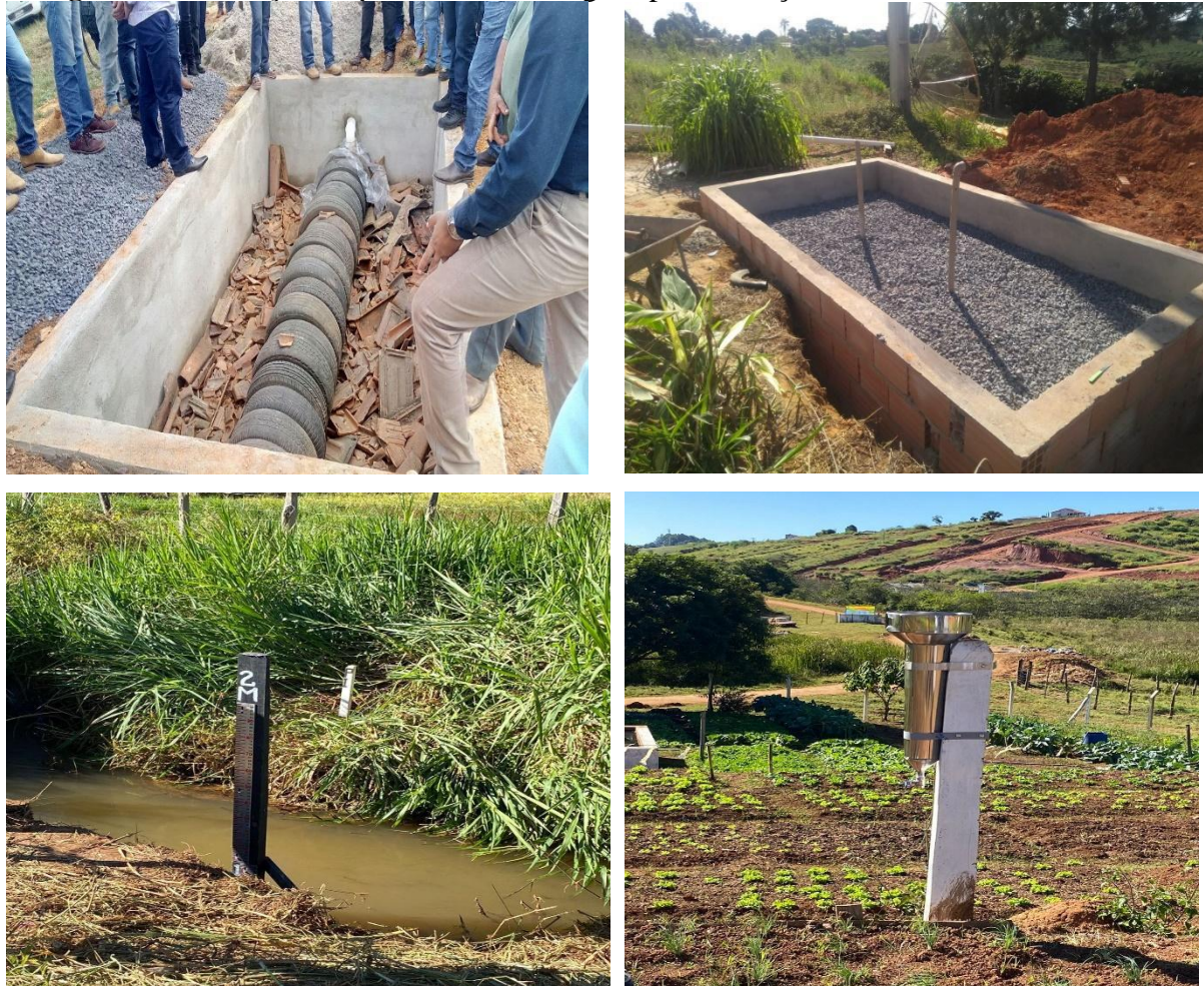
Figura 9 - Instalação de pluviômetros e réguas para medição de vazão dos mananciais.
