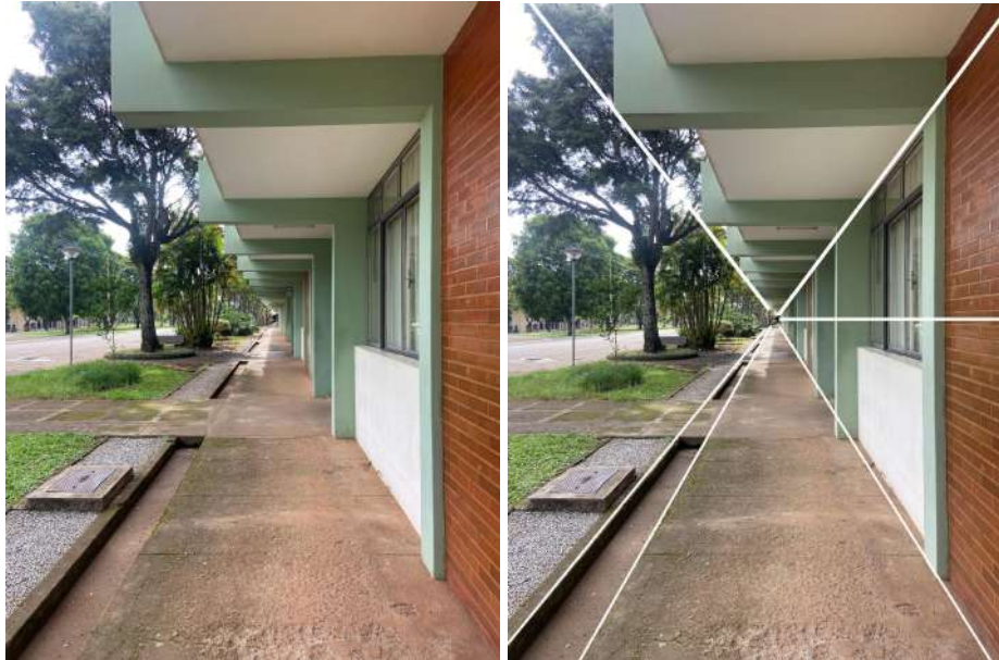
Figura 4.4 – Corredor externo do Departamento
