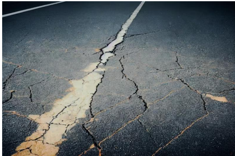
Figura 1 – Fissura asfáltica
