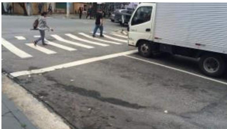
Figura 6 – Depressão asfáltica
