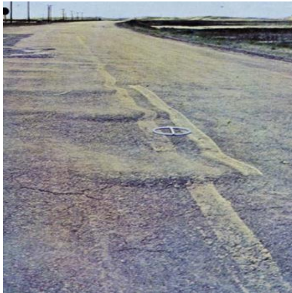
Figura 4 – Corrugação asfáltica
