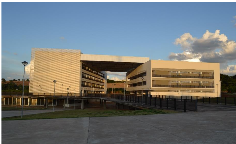
Figura 22 – Prédio Lavrastec no Campus da Universidade Federal de Lavras.
