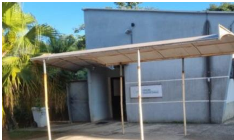
Figura 6 – Vista da fachada do setor de internação de cães e gatos do Hospital Veterinário da Universidade Federal de Minas Gerais.
