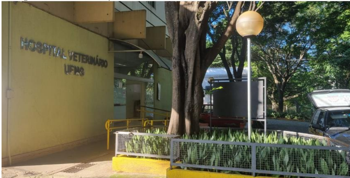
Figure 1 - Vista do Hospital veterinário da Universidade Federal de Minas Gerais.
