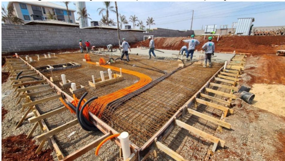
Figura 3.5 - Etapa da execução de uma fundação tipo radier.
