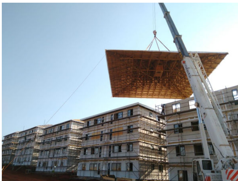
Figura 3.4 - Execução do telhado feito pela Tecverde.
