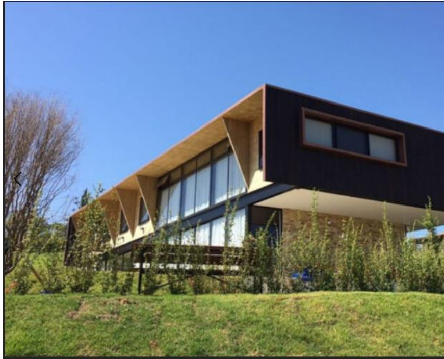
Figura 10 - Residência em Itu (lajes de piso e cobertura de CLT)
