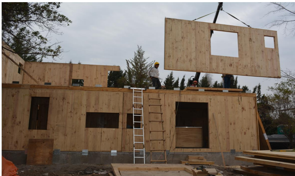
Figura 5 - Instalação de um painel CLT
