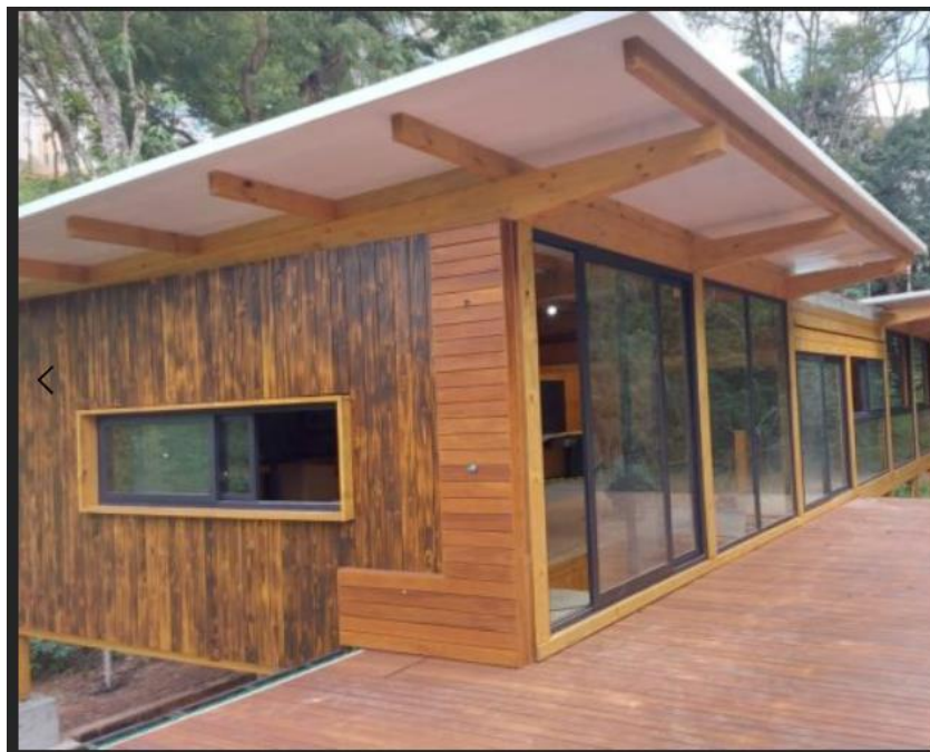
Figura 9 - Residência em Cajamar (Lajes de piso e cobertura com CLT)
