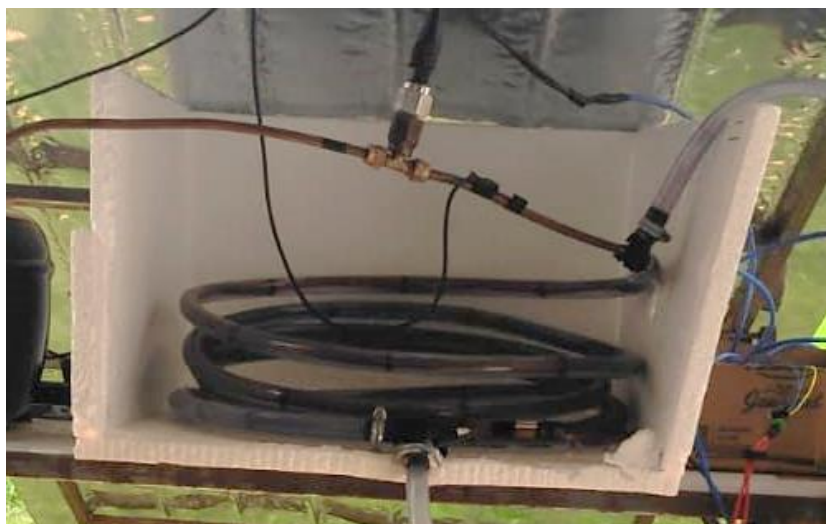
Figura 34 - Isolamento térmico do condensador
