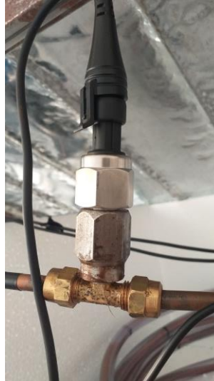
Figura 3.11 – Transdutor de pressão.
