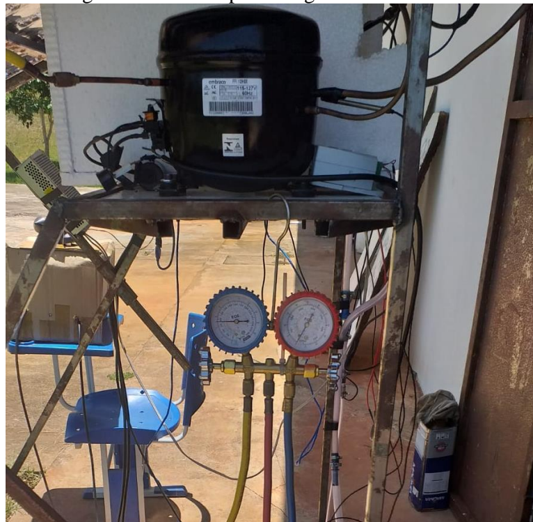
Figura 3.9 – Válvula para carregamento e manômetro
