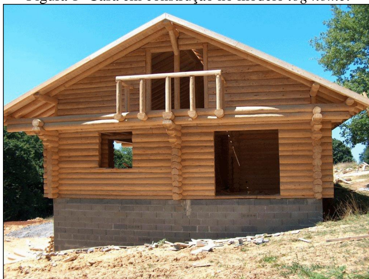
Figura 1- Casa em construção no modelo log home .
