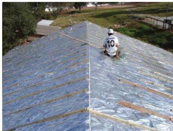
Figura 8 - Adição de manta de isolamento térmico ao forro da cobertura.
