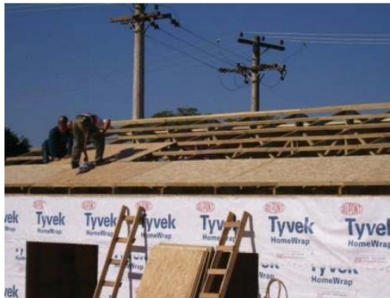
Figura 7 - Construção de forro com chapas de madeira.
