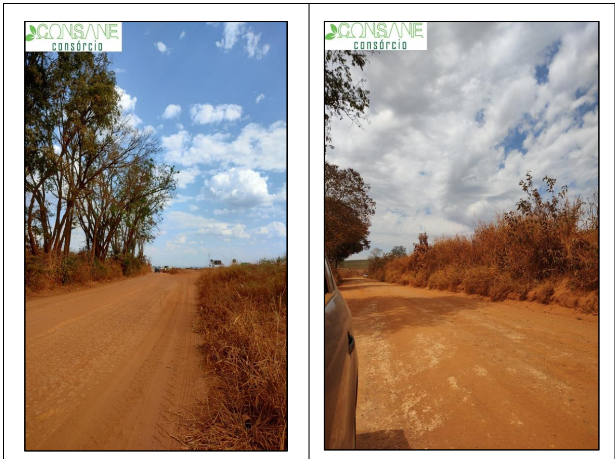
Figura 12 – Estrada Vicinal entre Campos Gerais e Córrego d’ Ouro (Conclusão).
