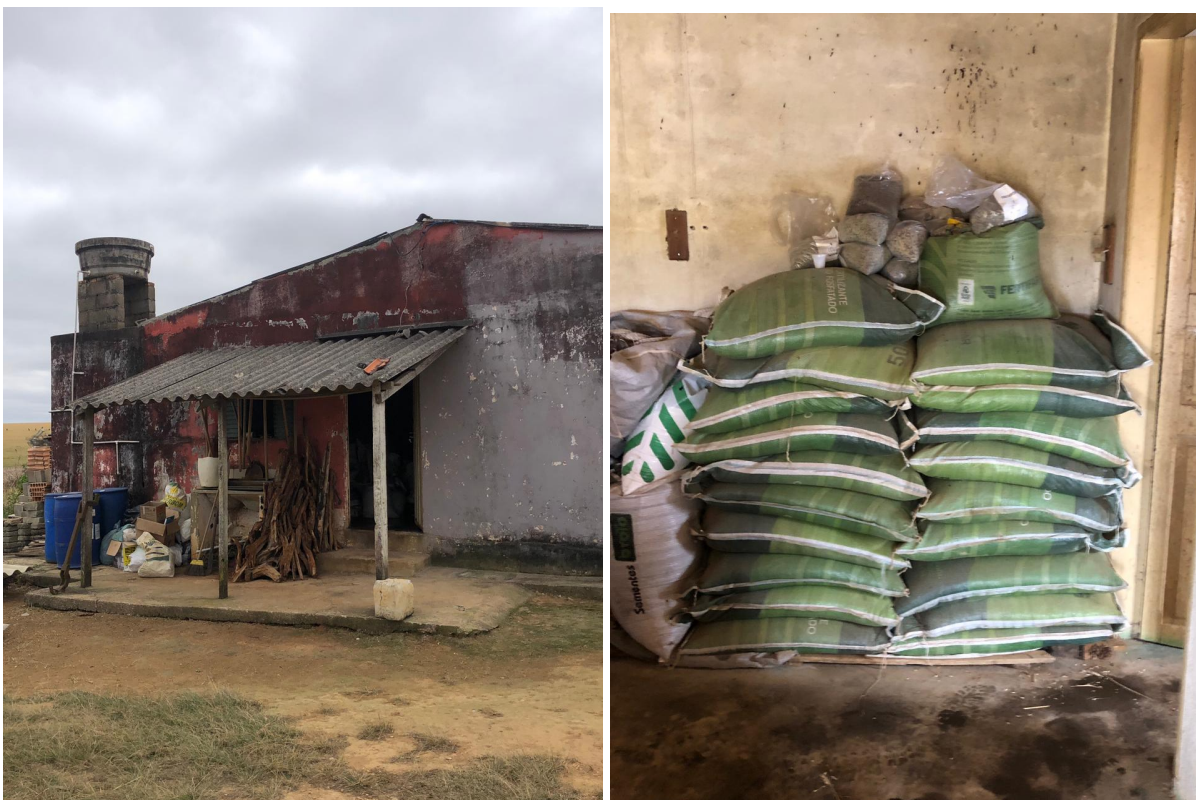
Figura 5- Barracão de armazenagem para fertilizantes e ferramentas.
