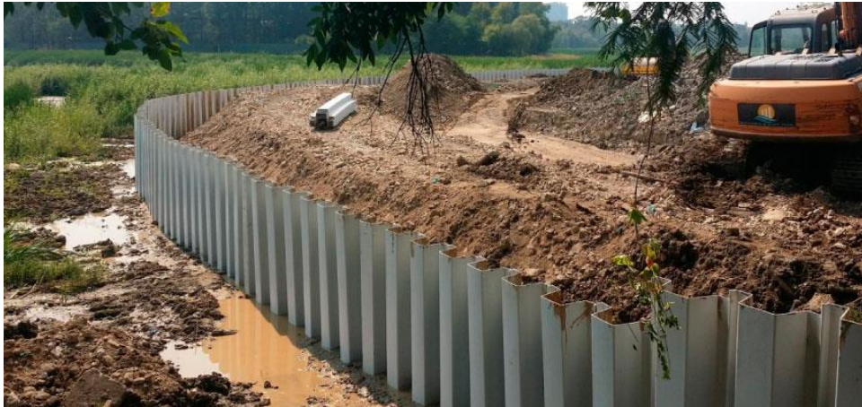
Figura 2.3 – Estaca-Prancha.
