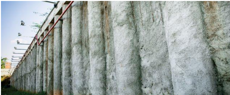
Figura 2.4 – Cortina de Estacas
