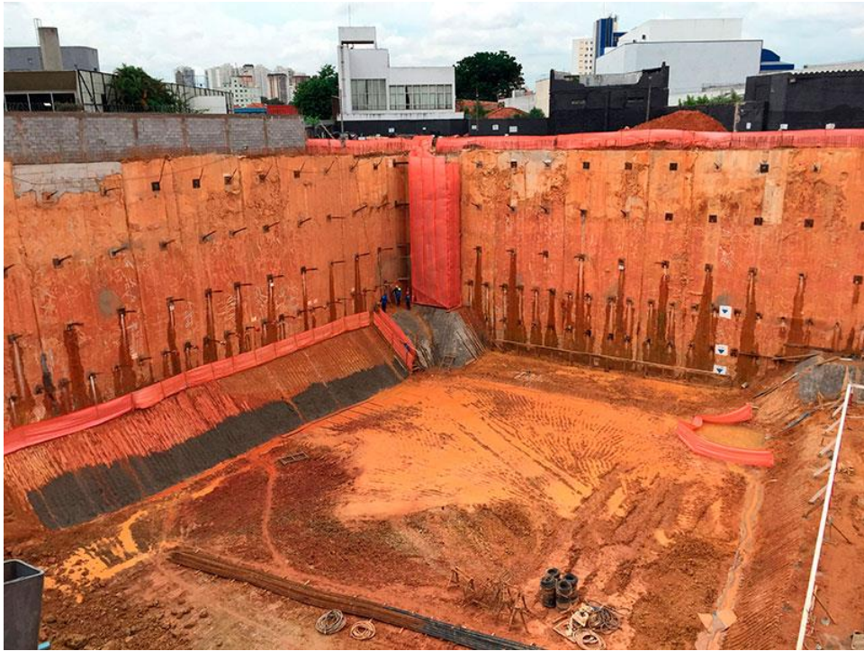
Figura 2.1 – Parede Diafragma.
