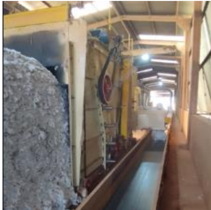
Figura 7 – Desmanchador de módulos e esteira transportadora
