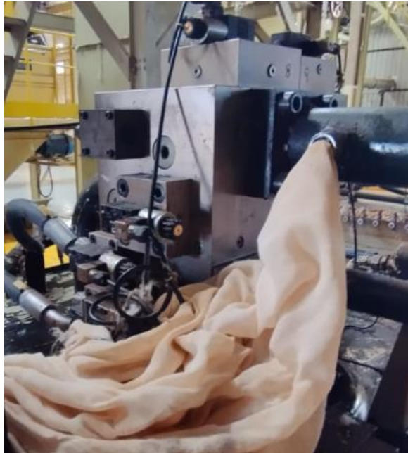
Figura 43 – Troca da mangueira hidráulica.
