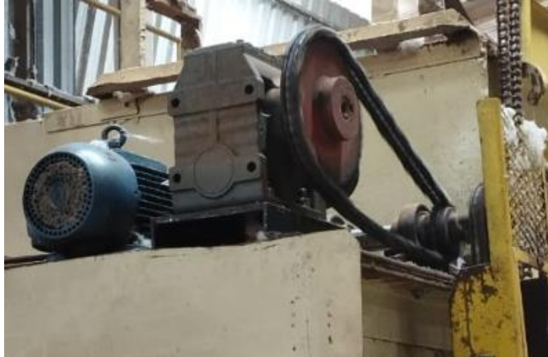
Figura 41 – Redutor, transmissão com a chapa, após manutenção
