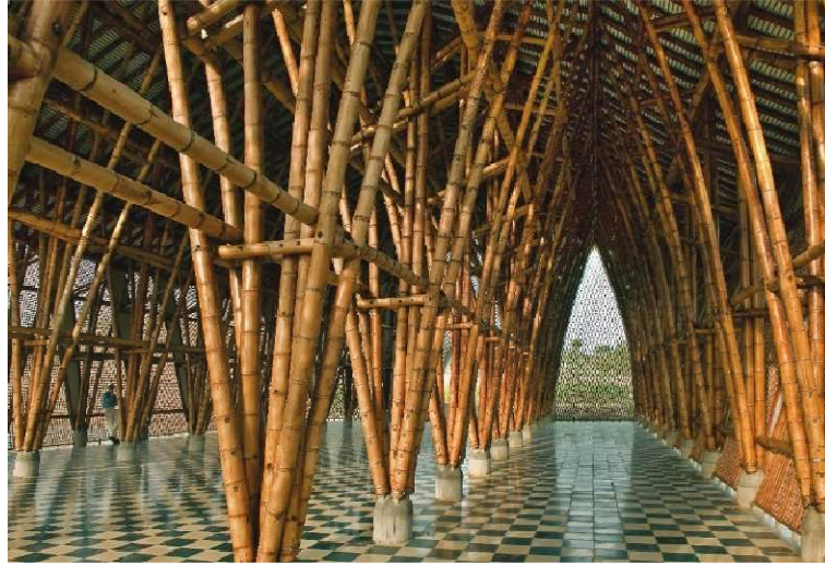
Figura 2 – Vista interior da Catedral de Pereira, Colômbia feita pelo arquiteto Simon Velez
