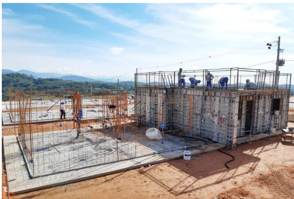
Figura 9 – Etapa construtiva parede de concreto – montagem das formas.
