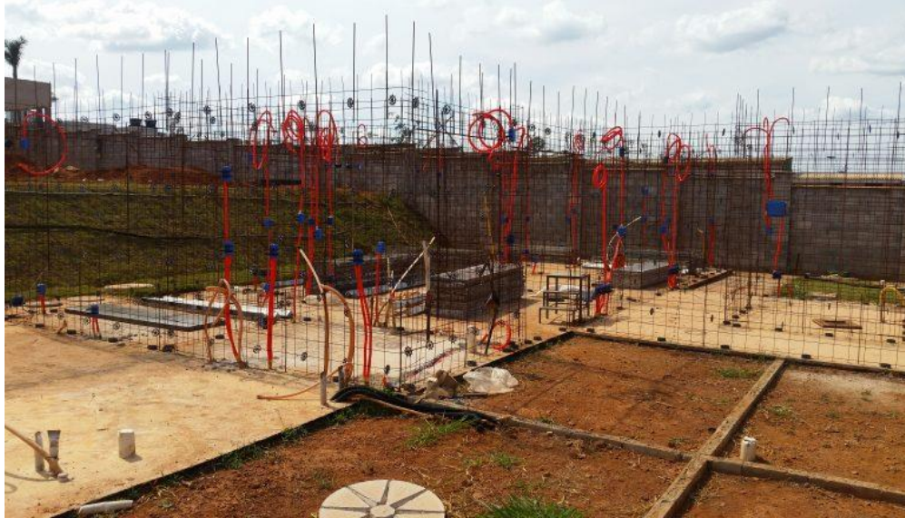
Figura 8 – Etapa construtiva parede de concreto – armação em tela soldada.
