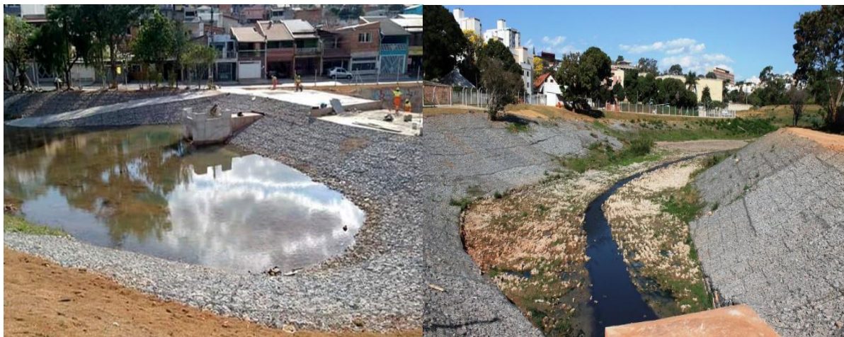
Figura 19a e 19b– Lagoa de retenção (Várzea Paulista-SP) e Área de retenção Rio do Nado (Belo Horizonte-MG).
