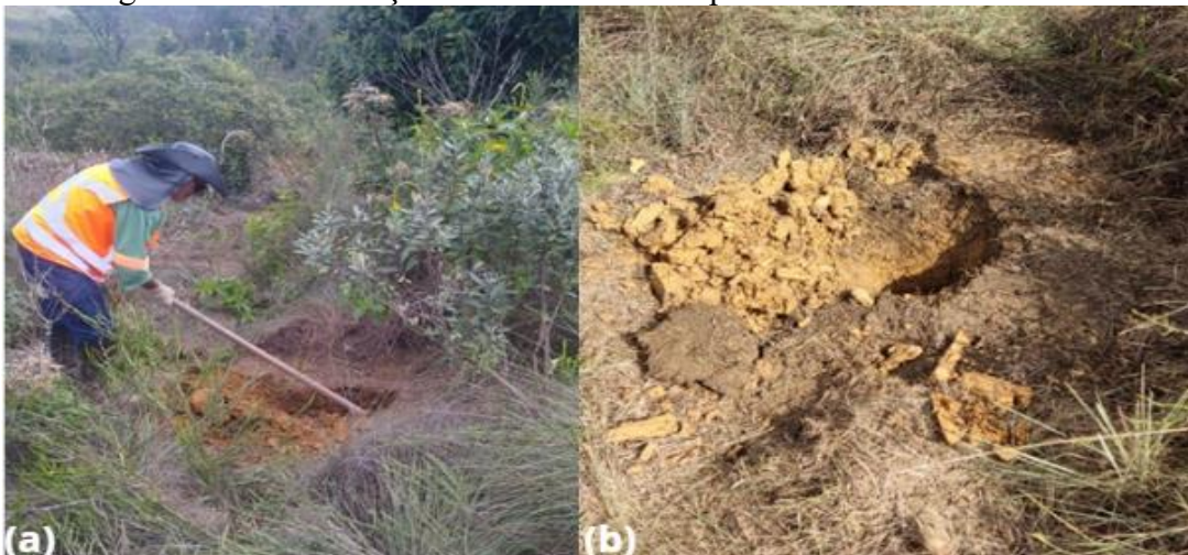
Figura 3.10 - Realização do coveamento na parte central do coroamento
