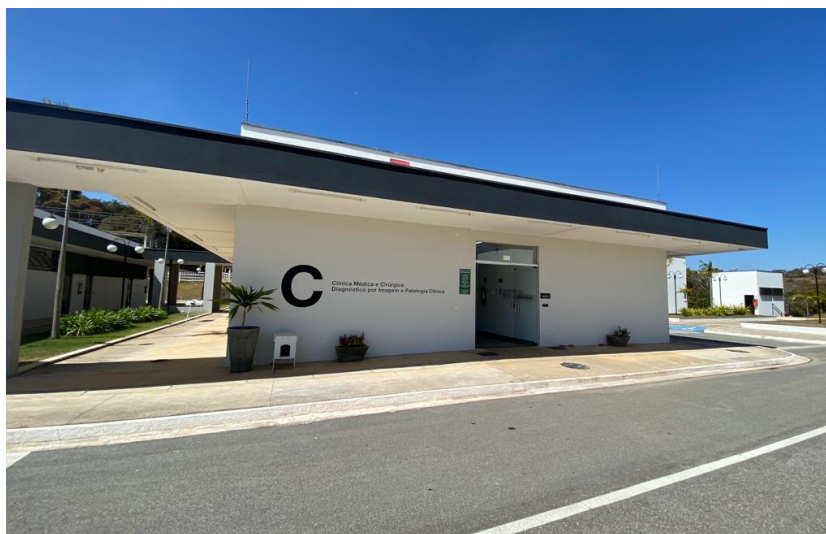
Figura 10 – Fachada de entrada do Bloco C.
