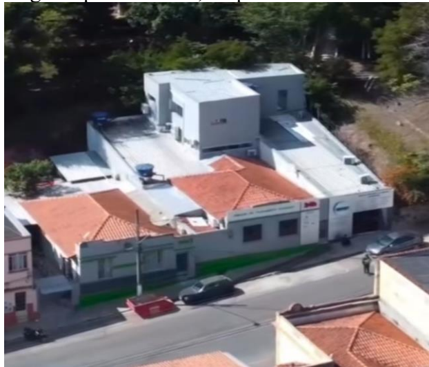
Figura 1- Vista aérea da Unidade Integrada Veterinária - UNIVET, Lavras/MG, onde foi realizado o estágio supervisionado, no período de 5 de abril a 5 de julho de 2023.
