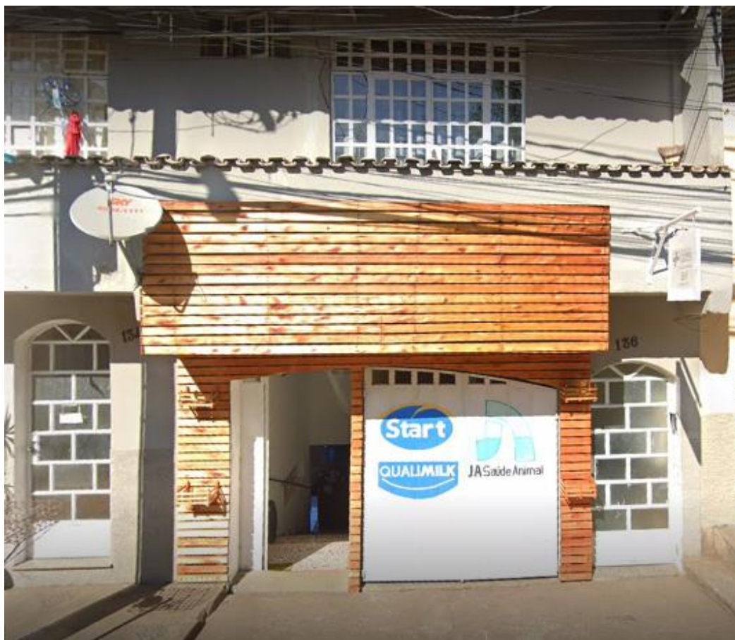
Figura 1-Fachada da empresa +LEITE localizada na cidade de São João Del Rei.
