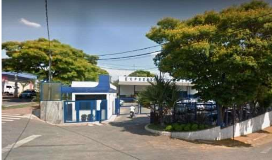
Figura 1: Fotografia do local de estágio, matriz Expresso Nepomuceno S/A
