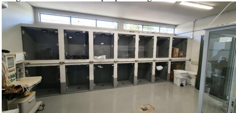
Figura 5- Sala de internação pré-cirúrgica do HV da UFMG.
