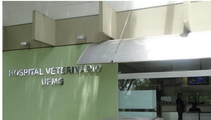
Figura 1- Fachada do Hospital Veterinário da UFMG.
