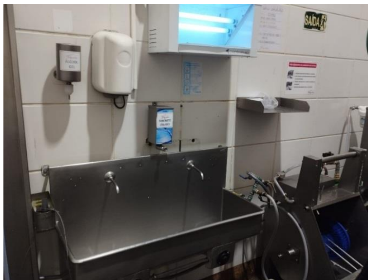
Figura 7- Exemplo de barreira sanitária do frigorífico de bovinos e suínos.
