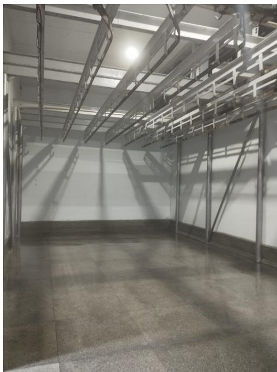
Figura 8- Exemplo de câmara fria do frigorífico destinada ao armazenamento de carcaças bovinas.
