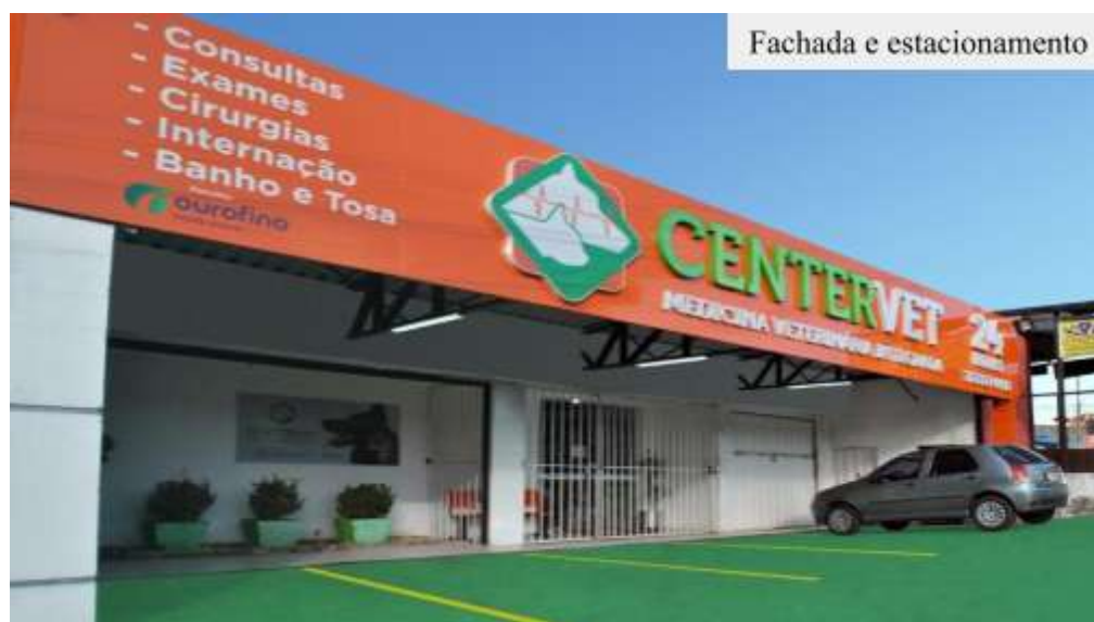
Figura 1- Fachada do HV Center Vet, unidade Industrial, Contagem-MG.
