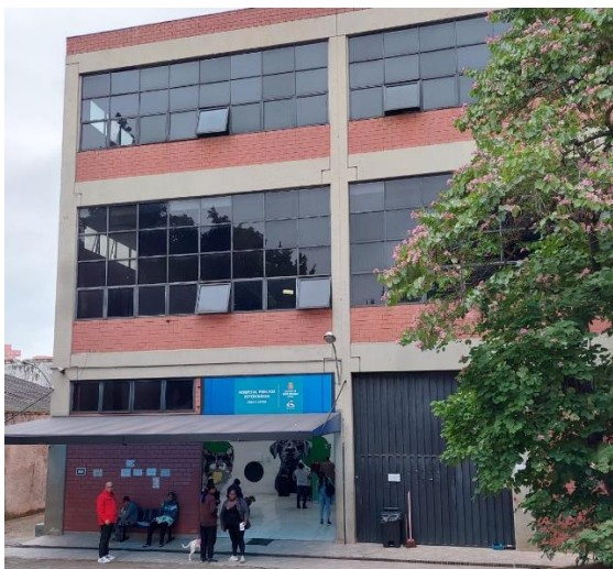
Figura 1 - Fachada do Hospital Veterinário Público ANCLIVEPA-SP, Unidade Norte em abril de 2023.
