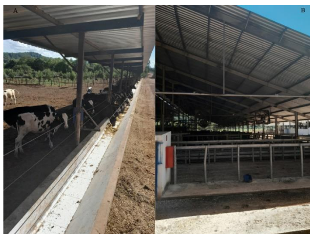
Figura 3- Instalações e Centro de manejo do Setor de Recria localizado no Galpão 1.
