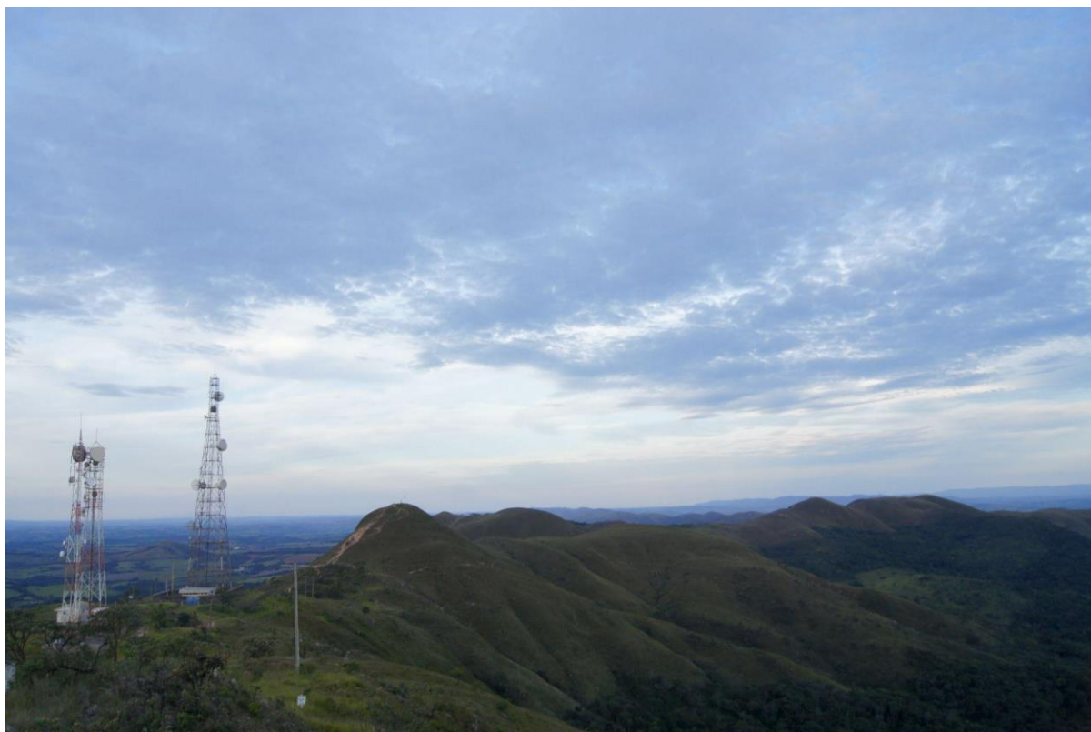
Figura 2 - Antenas de telecomunicação na crista da Serra da Bocaina, Lavras, MG
