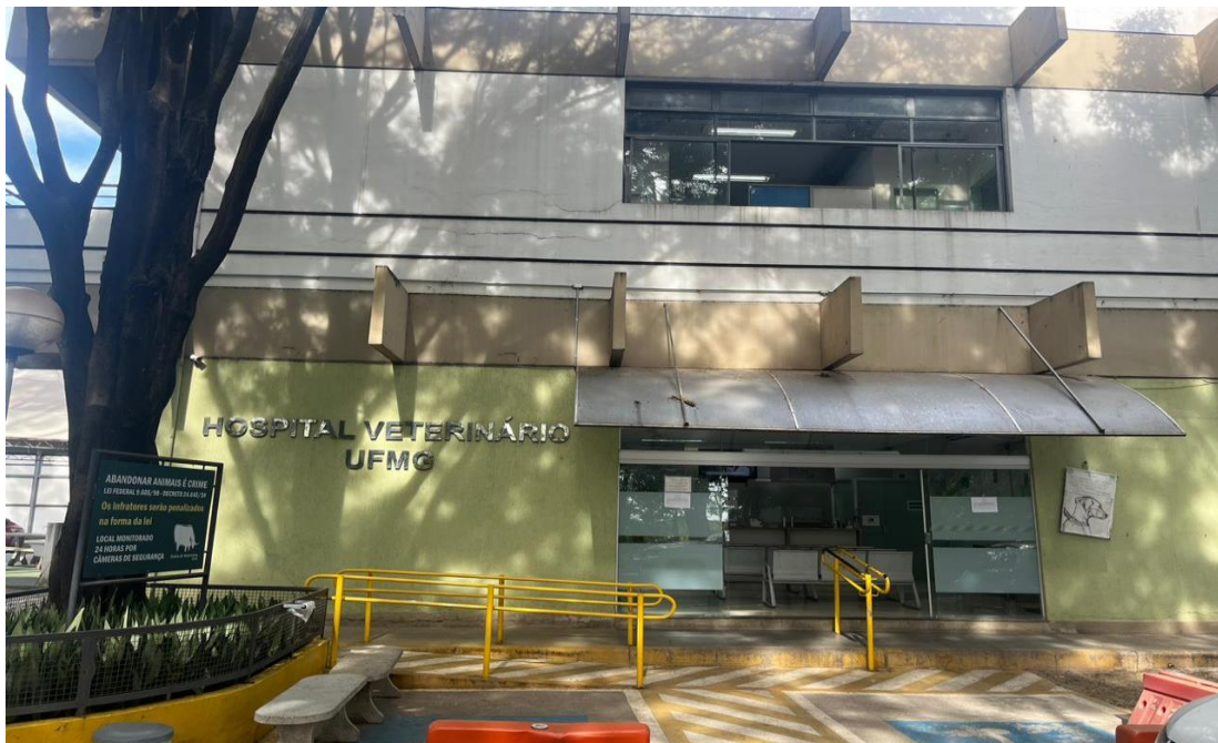
Figura 1 - Vista parcial da entrada do Hospital Veterinário da Universidade Federal de Minas Gerais.
