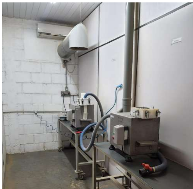
Figura 5 - Sala de moinhos.
