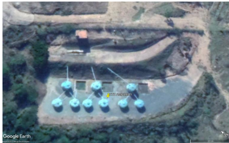
Figura 9: Estação de Tratamento de Esgoto (ETE Amparo I).
