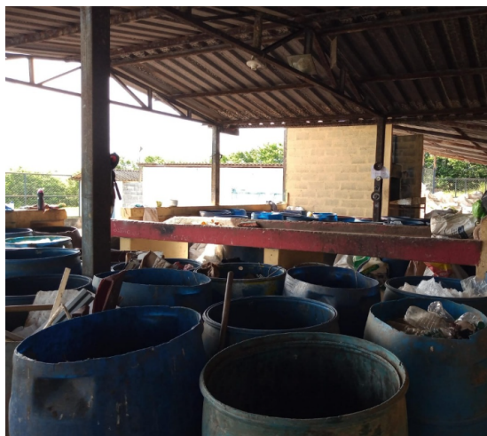
Figura 4. Vista interna da UTC.
