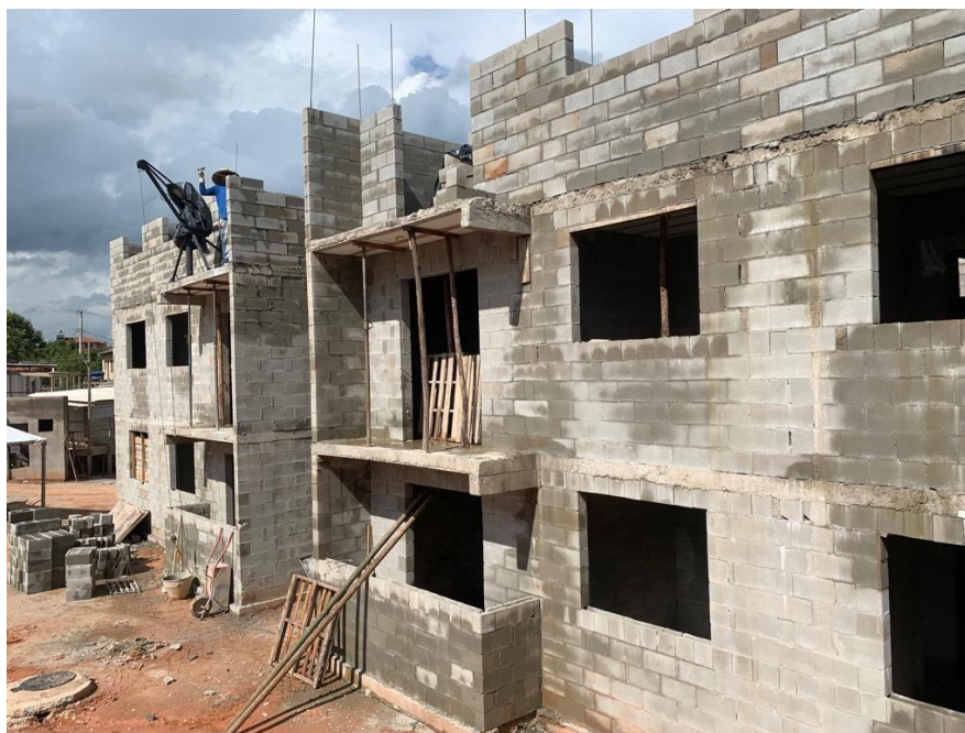
Figura 13 – Alvenaria estrutural do residencial Olympia sendo erguida.
