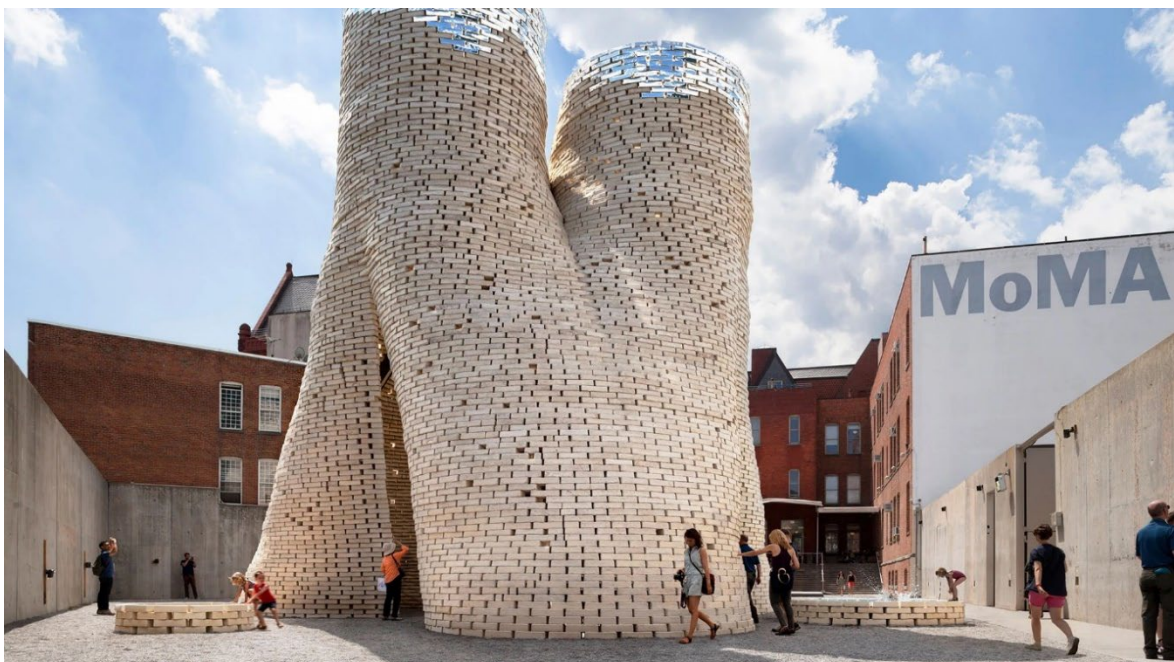
Figura 3 – A primeira torre construída com tijolos de micélio de fungos (Hy-Fi Tower).
