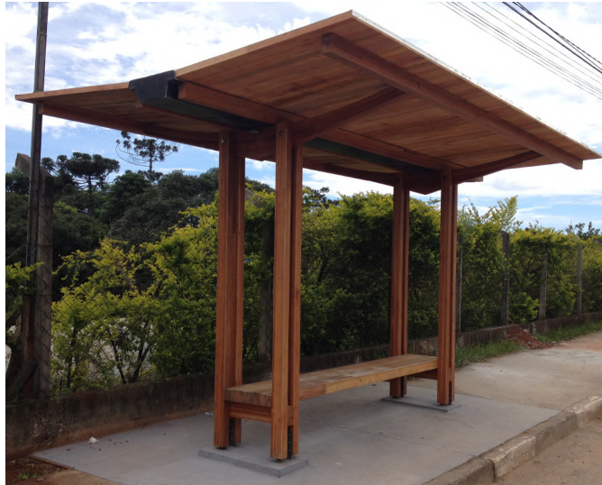
Figura 4 – Abrigo de ponto de Ônibus em MLC.
