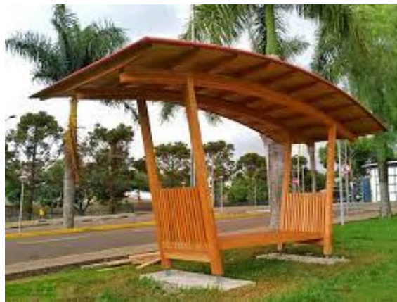
Figura 2 – Abrigo de ponto de Ônibus em MLC na USP.
