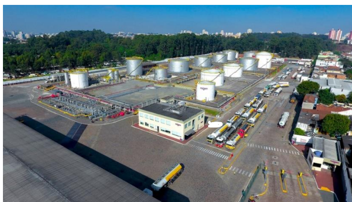
Figura 5 - Base de armazenagem e distribuição de combustíveis
