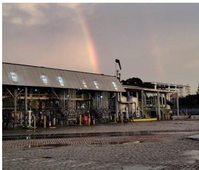
Figura 6 - Plataforma de carregamento e descarga
