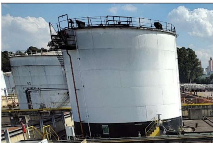
Figura 8 - Tanque de armazenagem de combustível
