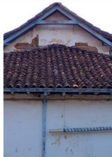
Figura 56 – Empena da Capela Mor
