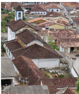
Figura 29 - Vista geral da cobertura. Foto: Tamara Pereira - 07/2014
