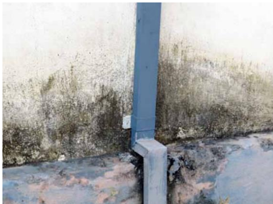
Figura 13 - Detalhe da parede da fachada lateral direita. Foto: Sandra Fosque - 07/2014
