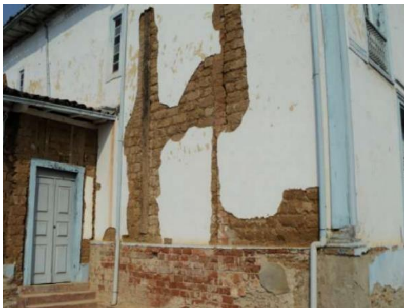
Figura 3 - Obras de restauro em 2002
