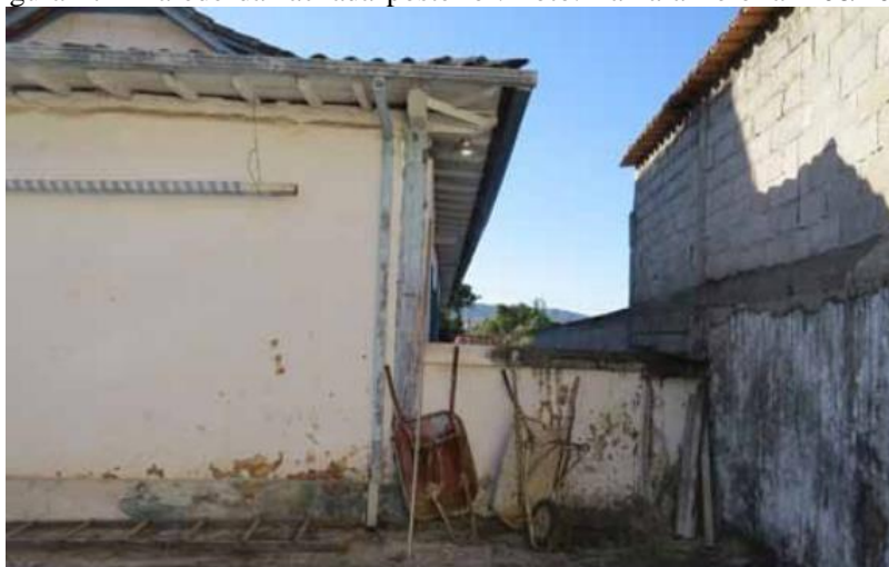
Figura 27 - Parede da fachada posterior. Foto: Tamara Pereira - 08/2014
