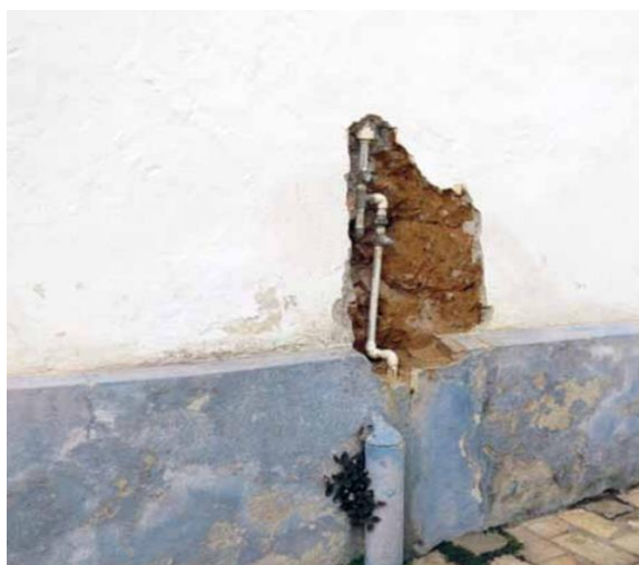
Figura 14 - Detalhe da parede da fachada lateral direita. Foto: Sandra Fosque - 07/2014
