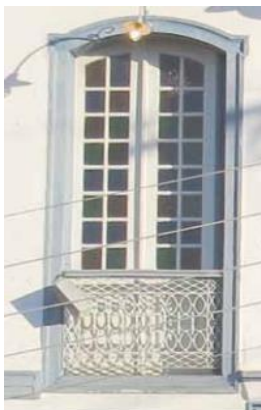
Figura 34 - Janela fachada principal Foto: Sergio Sanches
