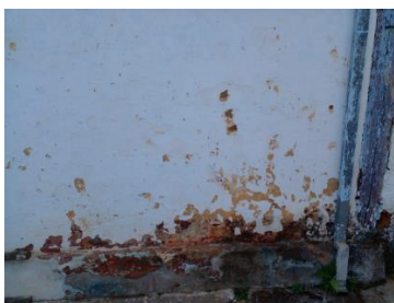
Figura 50 – Detalhe da fachada posterior
