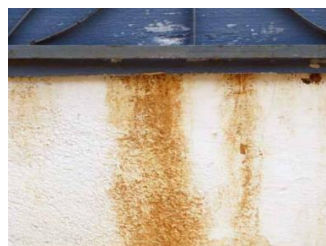
Figura 22 - Detalhe da parede da fachada lateral esquerda. Foto: Pedro Bui - 07/2014
