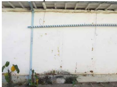
Figura 26 - Parede da fachada posterior. Foto: Tamara Pereira - 08/2014
