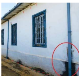
Figura 16 - Fachada lateral esquerda. Foto: Sérgio Sanches - 07/2014
