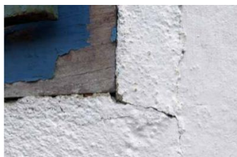
Figura 21 - Detalhe da parede da fachada lateral esquerda. Foto: Pedro Bui - 07/2014
