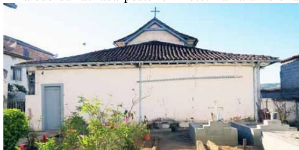
Figura 25 - Parede da fachada posterior. Foto: Tamara Pereira - 08/2014
