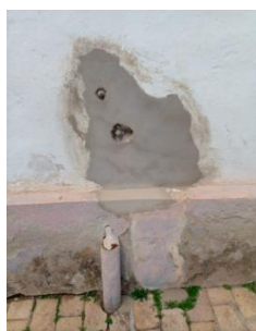
Figura 41 – Intervenção no sistema hidráulico
