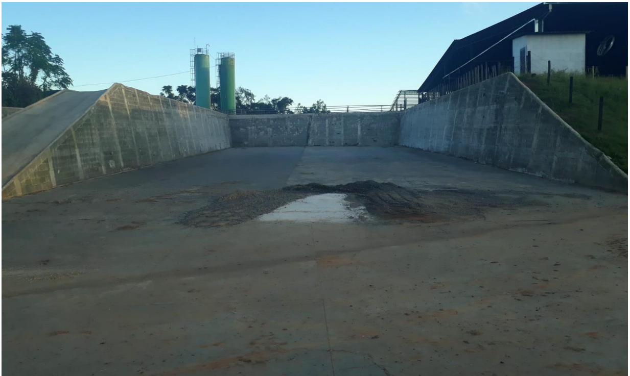
Figura 9 - Silo trincheira em alvenaria vazio de uma das propriedades acompanhadas
