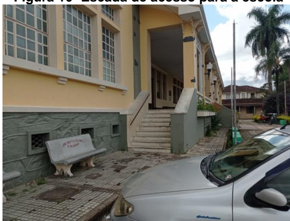
Figura 10- Escada de acesso para a escola
