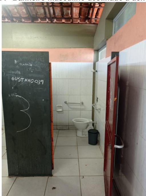
Figura 7- Banheiro masculino destinado à deficientes
