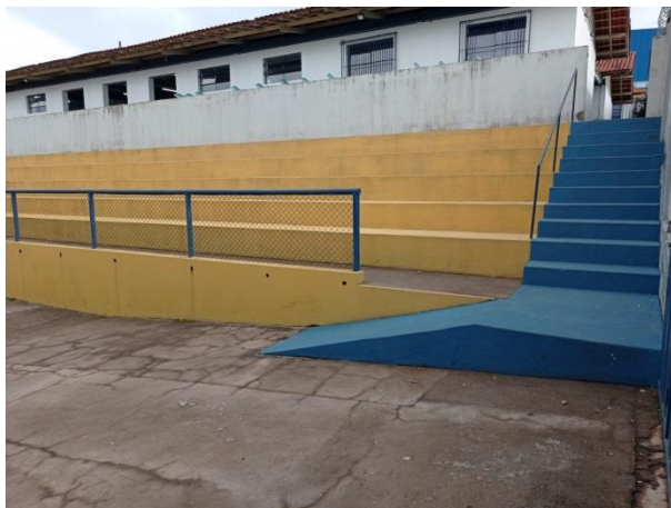
Figura 1- Rampa de acesso à arquibancada
