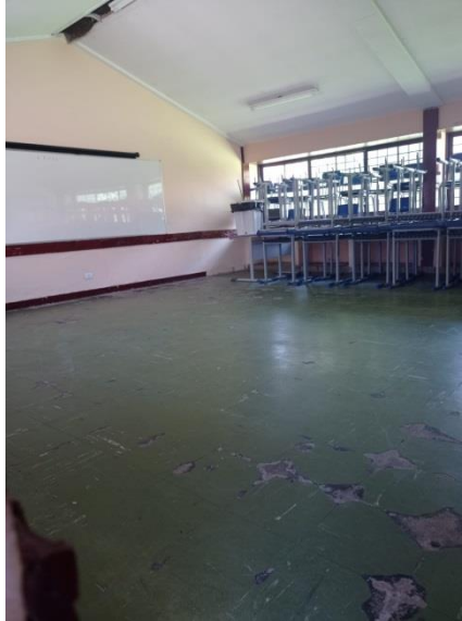
Figura 9- Interior da sala de aula
