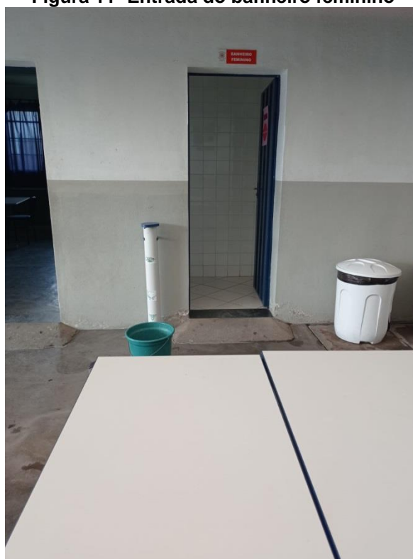
Figura 11- Entrada do banheiro feminino
