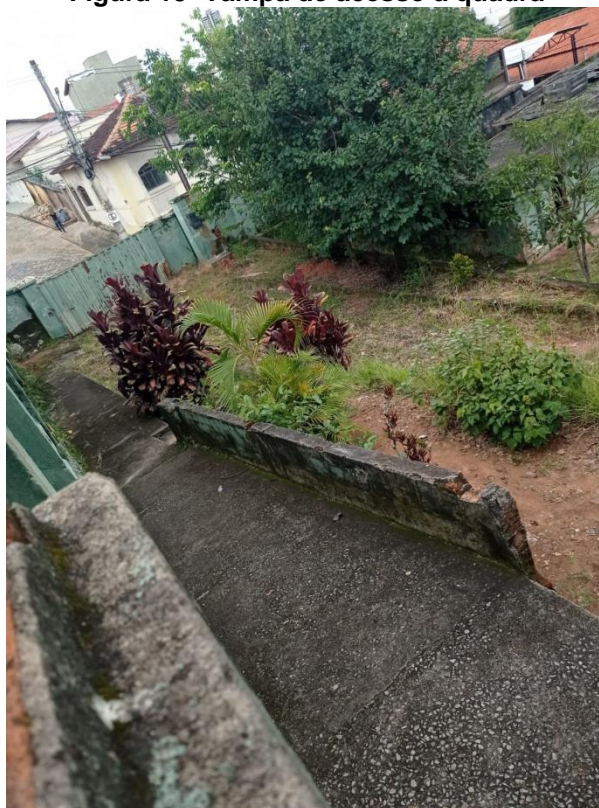
Figura 13- Tampa de acesso à quadra
