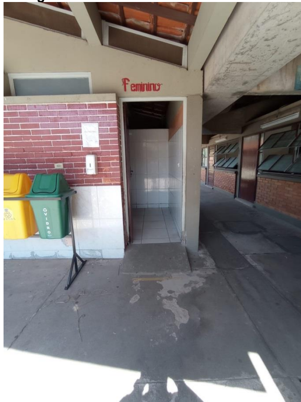
Figura 13- Entrada do banheiro feminino
