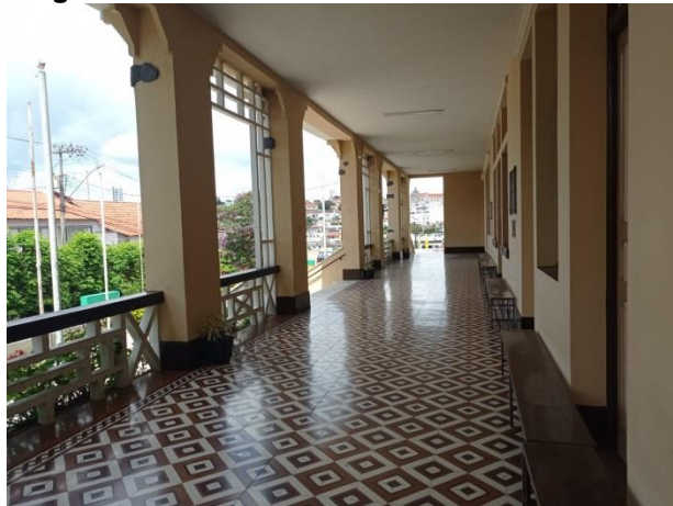
Figura 6- Corredor de acesso às salas de aula
