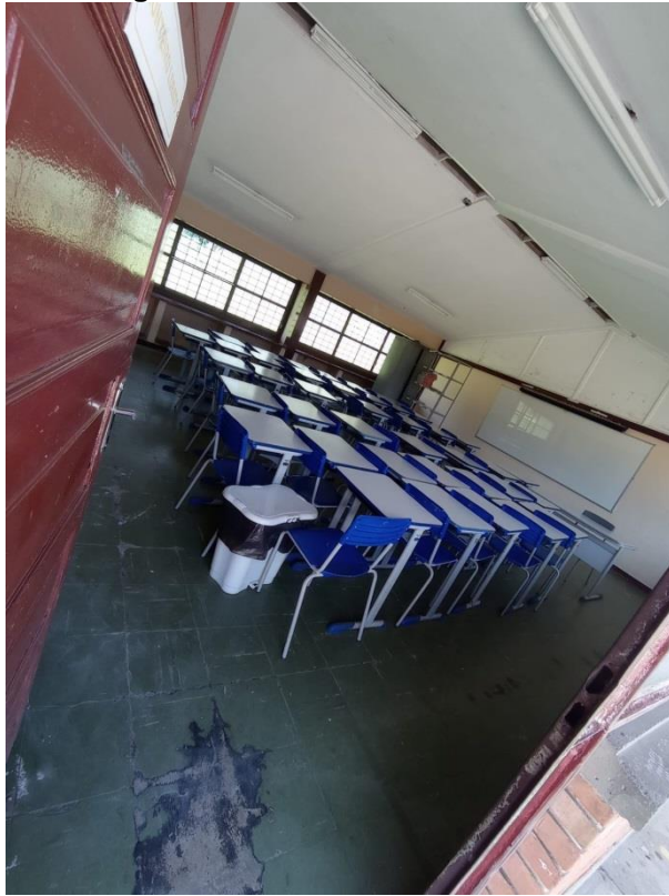
Figura 12- Interior da sala de aula
