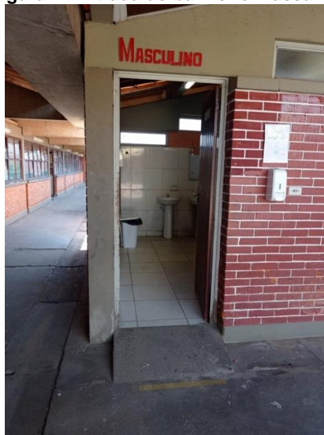
Figura 4- Entrada do banheiro masculino
