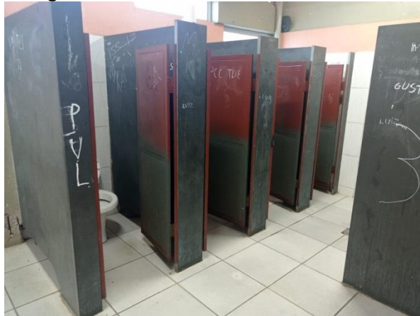
Figura 5- Cabines do banheiro masculino
