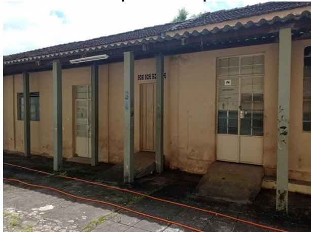
Figura 7- Salas de aula que ficam na parte inferior da escola
