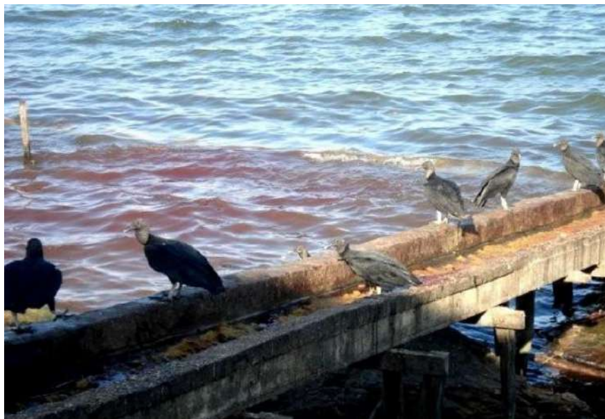
Figura 13 - Contaminação ambiental por resíduos de abates clandestinos.
