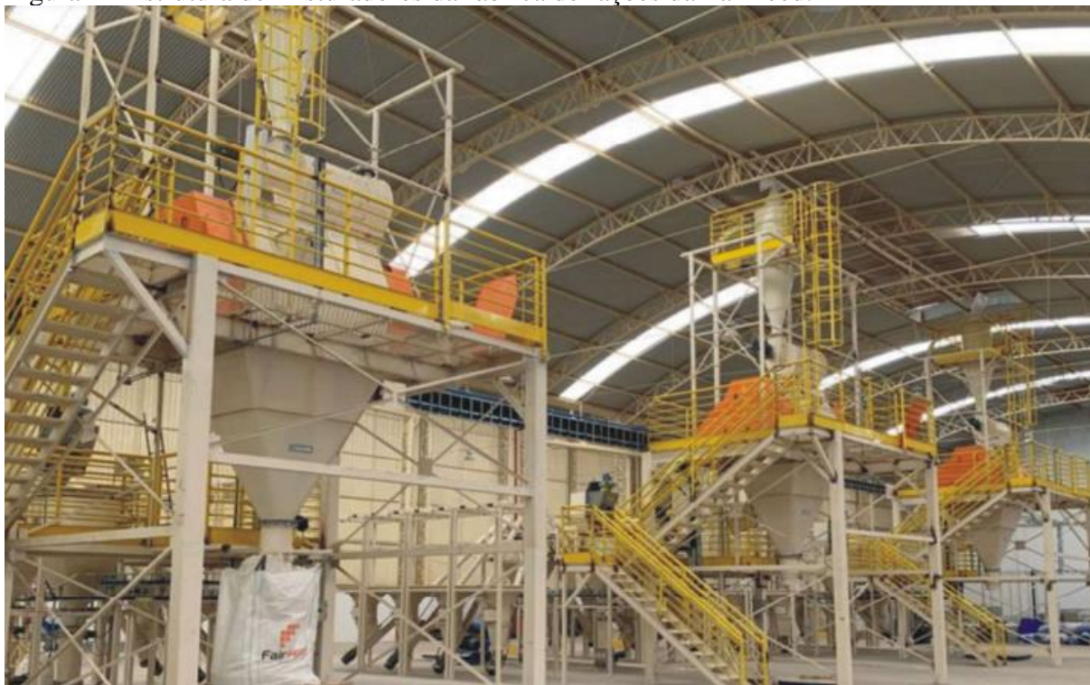
Figura 1 - Estrutura de misturadores da fábrica de rações da FairFeed.
