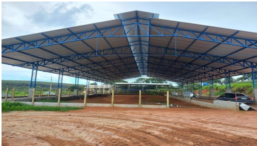
Figura 7 -Compost barn em construção.
