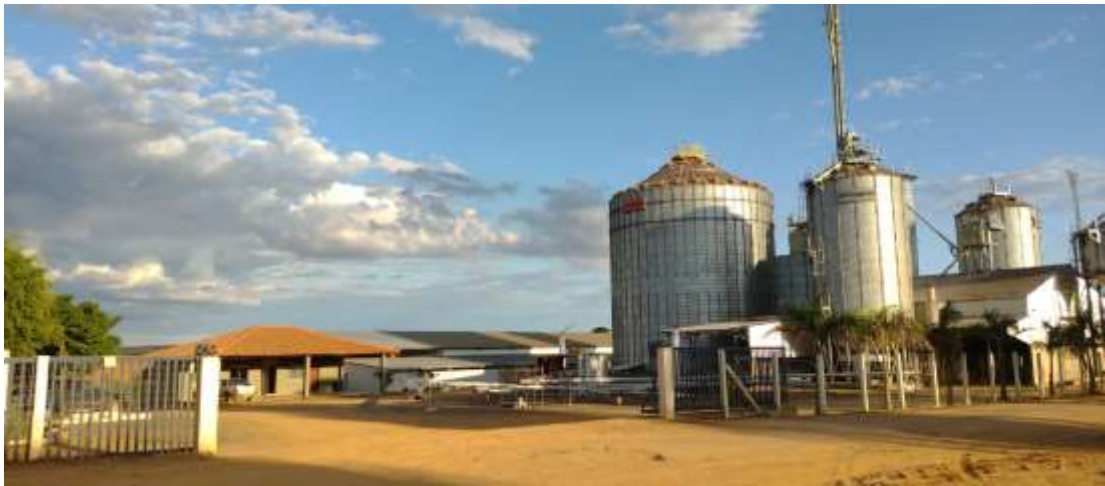
Figura 1 – Vista da fachada da Fazenda G7
