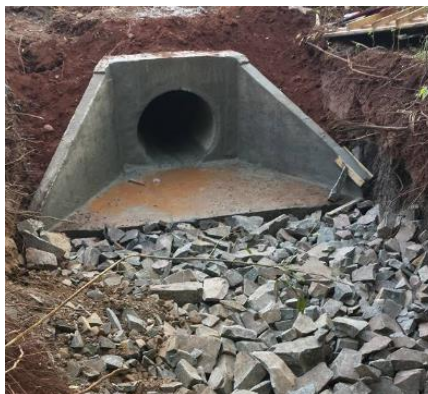
Figura 9 – Dissipador de energia constituído de enrocamento.
