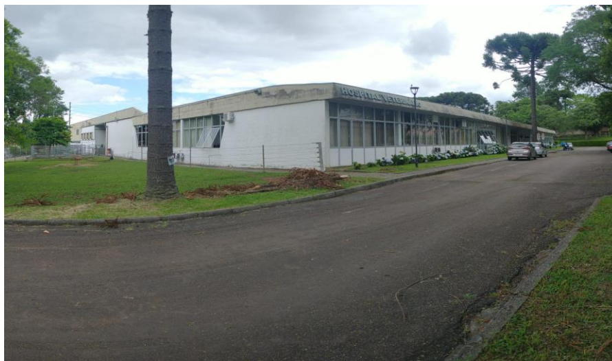
Figura 3: Fachada do hospital veterinário da Universidade Federal do Paraná
