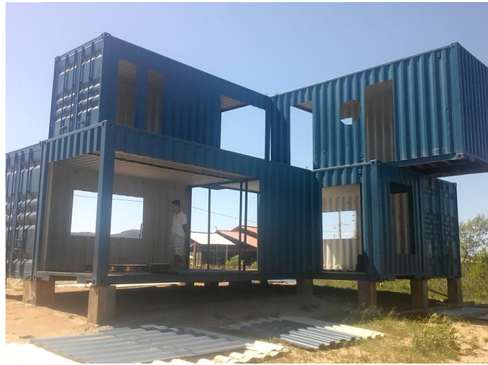
Figura 14 - Casa container apoiada sobre sapatas isoladas.
