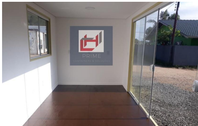
Figura 18 - Piso de compensado naval do container.
