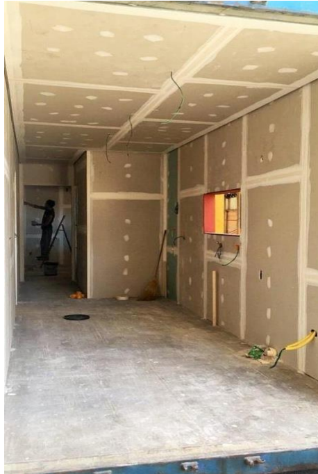
Figura 17 - Aplicação de painéis de gesso acartonado no interior do container.
