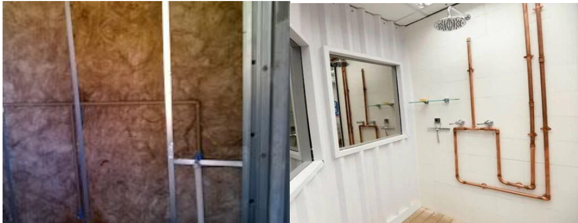
(16a) Instalações embutidas na parede
